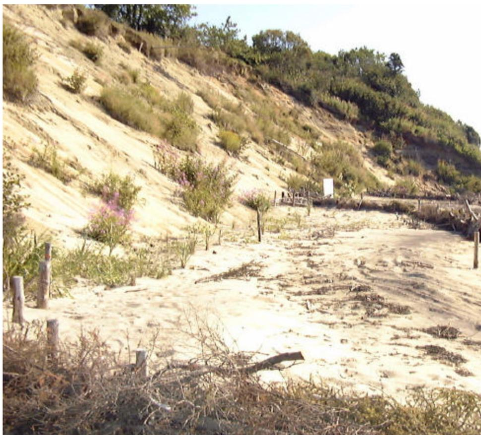
**Figure 40 - Plantation d'élyme réalisée à la mi-juin entre les SEMS 2 et 3**
