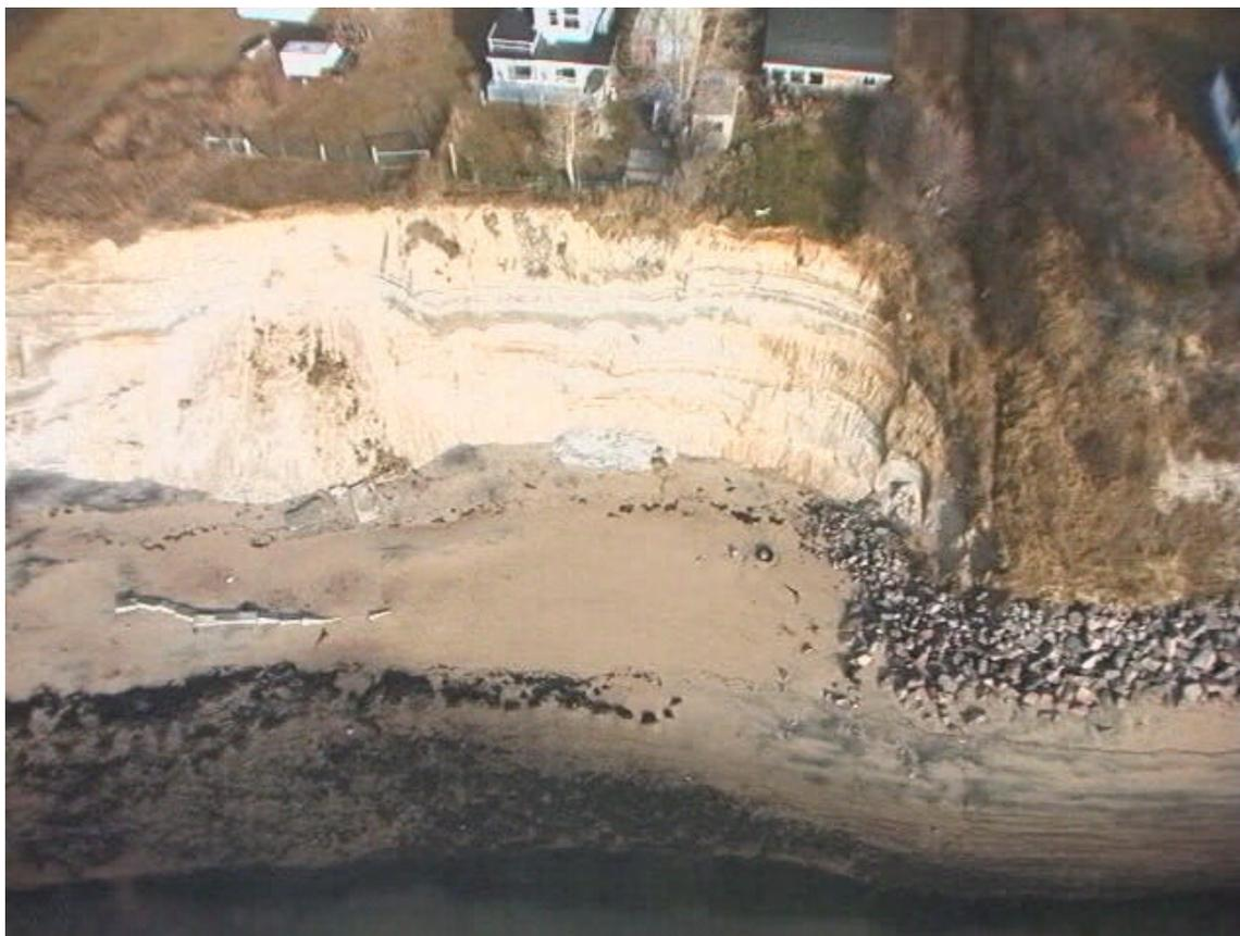
**Figure 8: Vue aérienne oblique (octobre 2000) du secteur à protéger (effets d'érosion dans la zone de bout d'enrochement du talus)**
