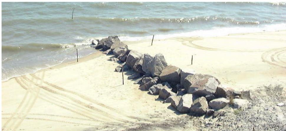
**Figure 25 - Photographie de l'épi rocheux (à l'ouest de la zone du suivi) en présence des cinq poteaux du suivi**
