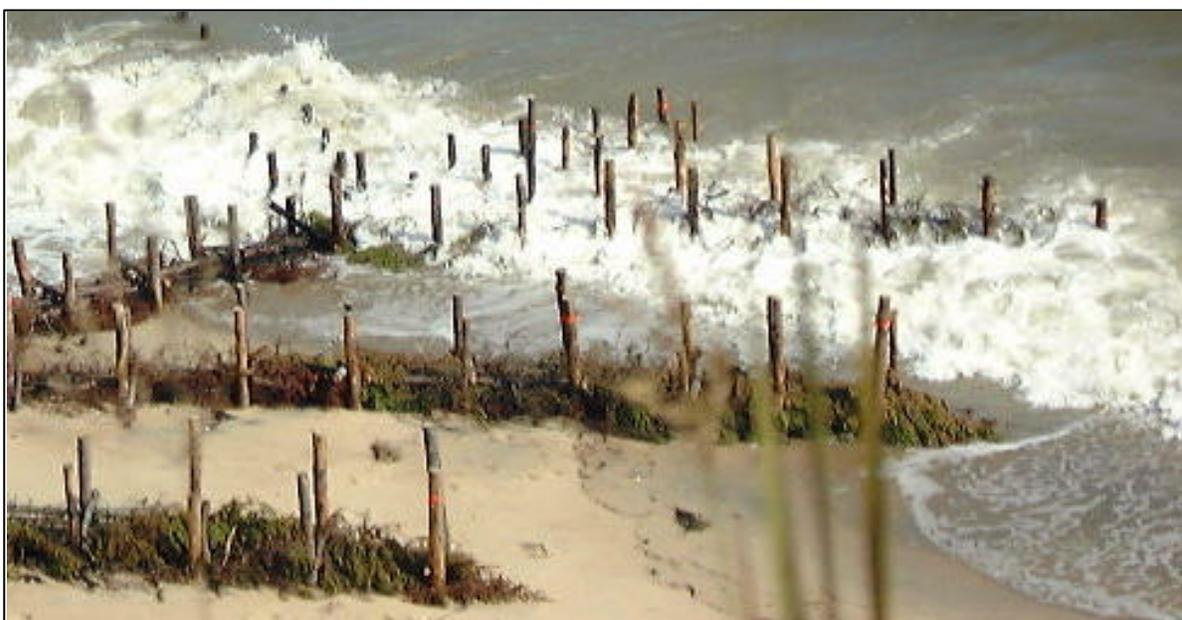
**Figure 4 Concept de fonctionnement (photo à l'appui) de l'épi perméable double en présence de vagues et de courants - filtre poreux et rugueux.**
