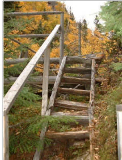
**Photo 10 :** Belvédère donnant vue sur la chute de la rivière Mistassini. Le mauvais état des structures de bois rend leur utilisation dangereuse.
