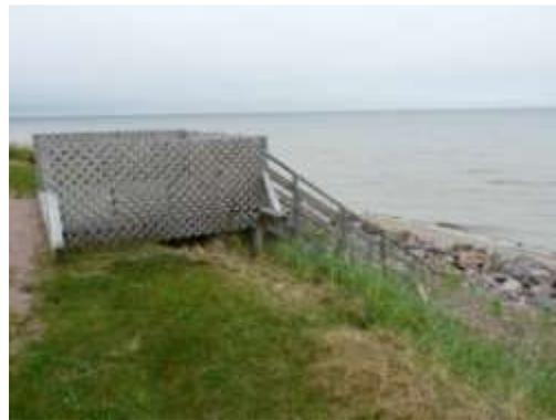
**Photo 13 :** Ancien escalier hors d'usage à cause de l'érosion
