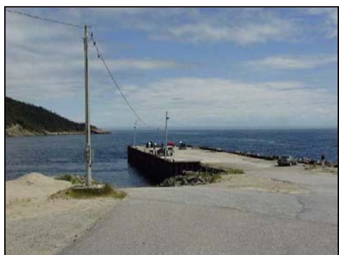
Photo 19.5 : quai municipal de Godbout
