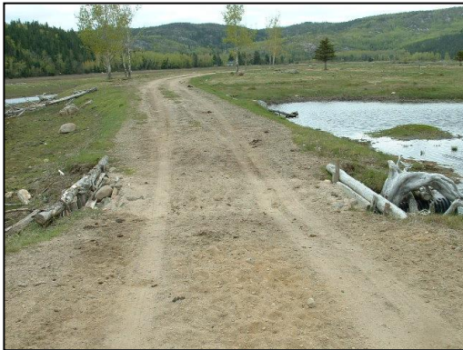
Photo 3 : Sur la rive gauche de la baie des Petites Bergeronnes, une portion du territoire situé au sud de la route provinciale 138 aurait autrefois fait partie intégrante de l'herbaçaiie salée située à proximité. Coupé de ses apports en eau salée par un chemin, ce milieu se serait progressivement transformé en prairie à graminées.
