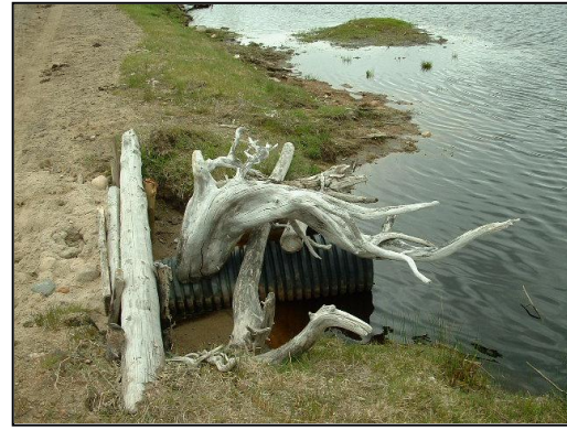
Photo 9 : Le milieu ne semble aujourd'hui alimenté en eau salée que par quelques tuyaux placés sous le sentier, ce qui limite le débit.
